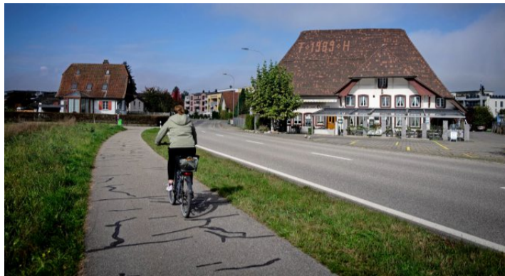
Ab dem Gasthof Bären, in der rechten Bildhälfte, zieht sich die Hauptstrasse durchs Dorf. Nun soll sie in einem grossen Projekt saniert werden. Bild: David Walgis
